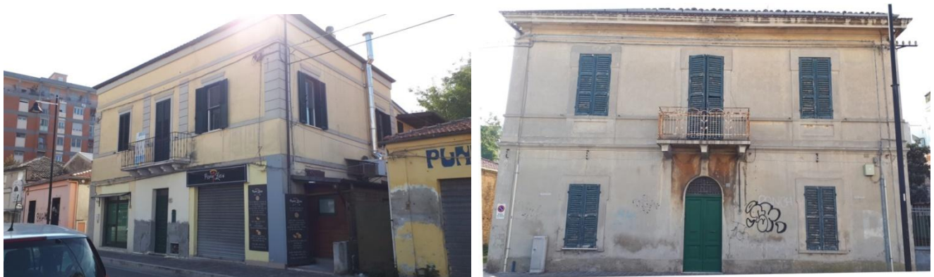
Fig 4 e 5: foto edifici via Gobetti da conservare e recuperare a destinazione privata
