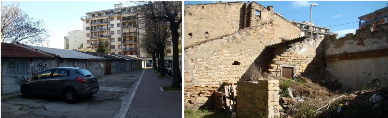
Fig 8 e 9: foto edifici via Lazio e in via Marche da demolire e ricostruire
