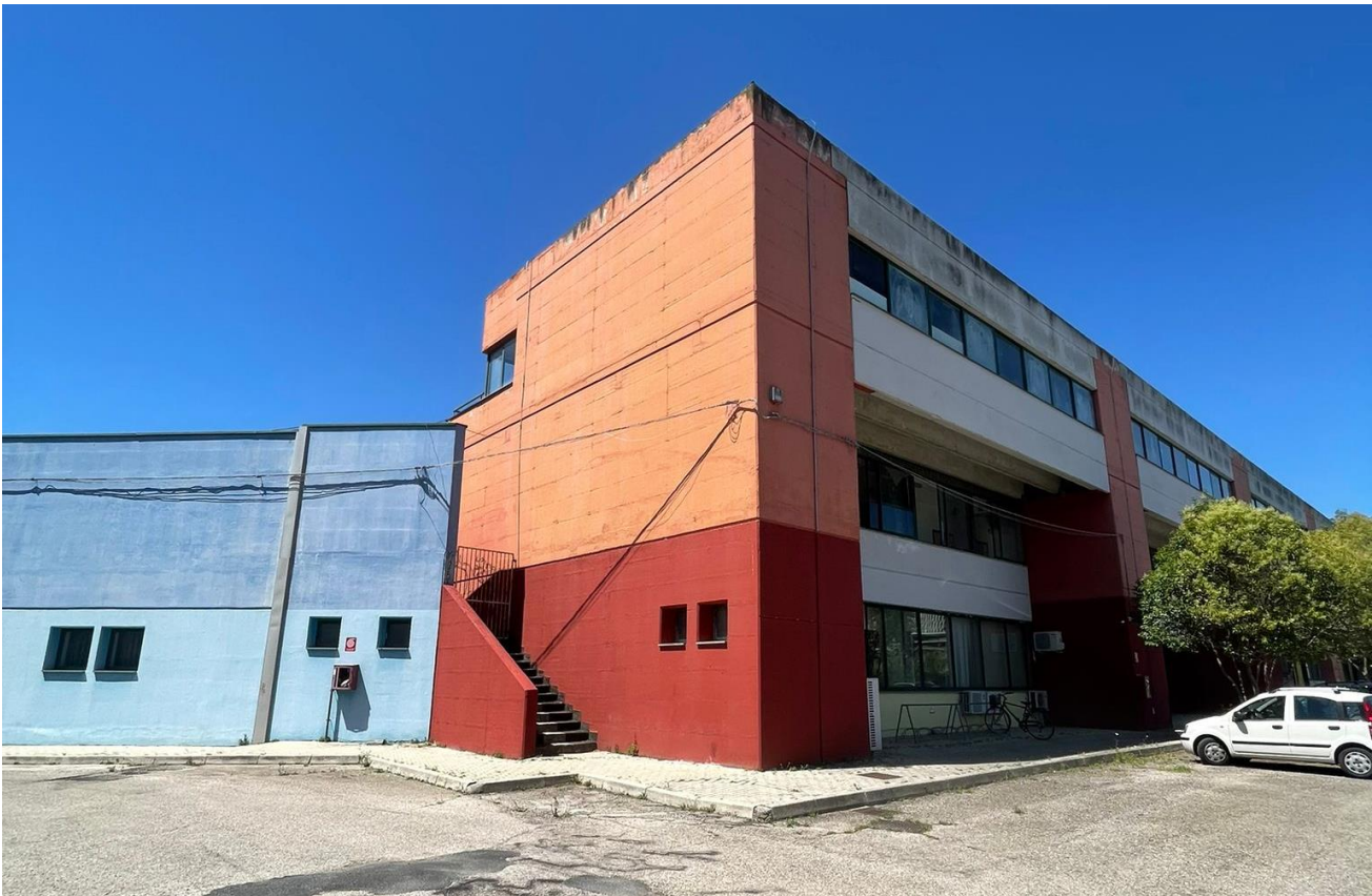
Fianco Nord dell'edificio esistente
