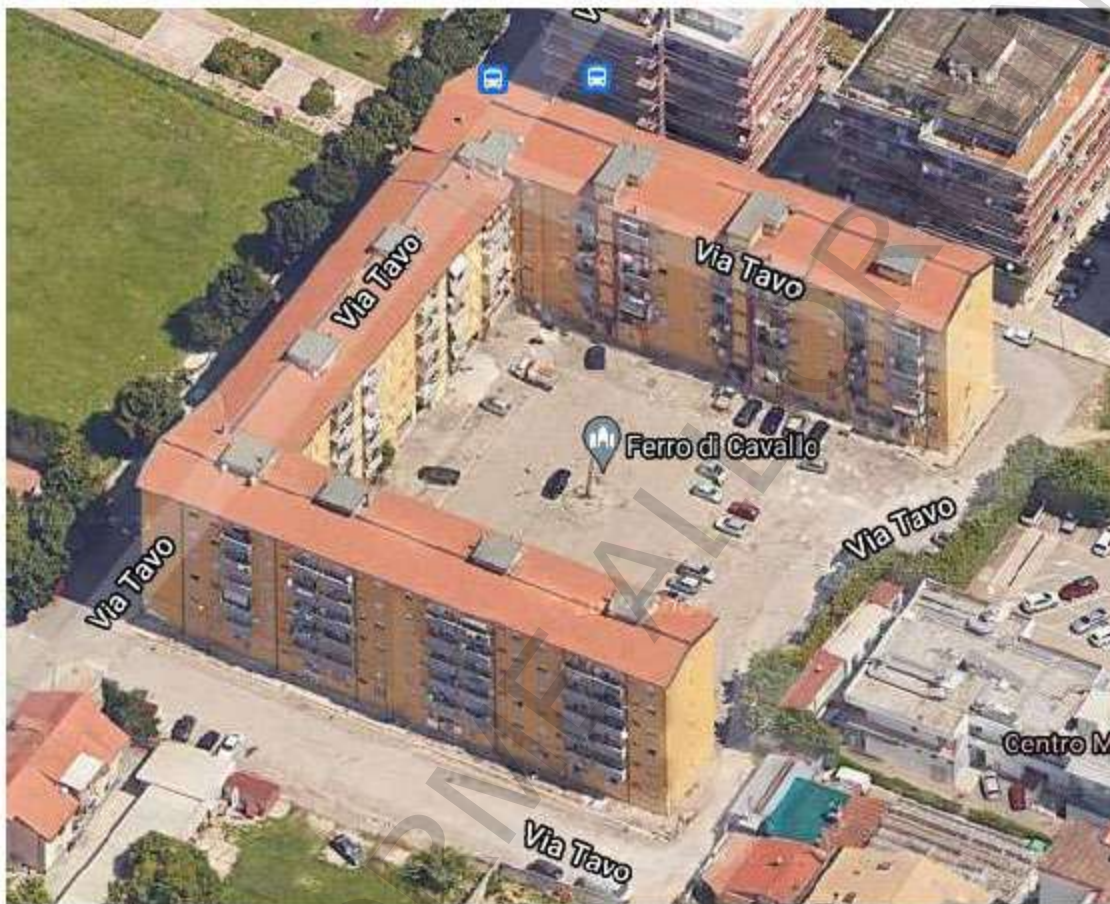
Situazione Esistente Prima della Demolizione
