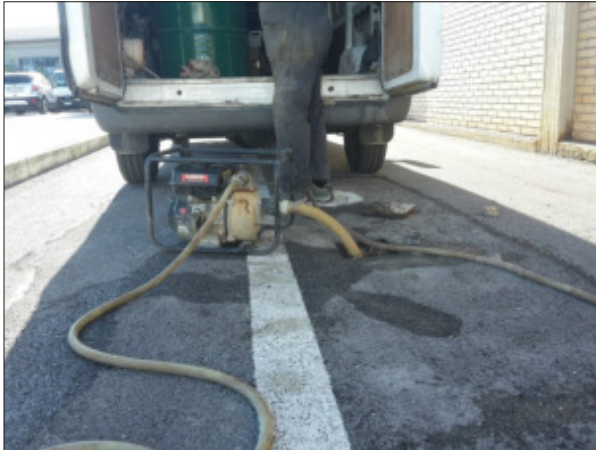
1) Pompa utilizzata per lo spurgo del piezometro
