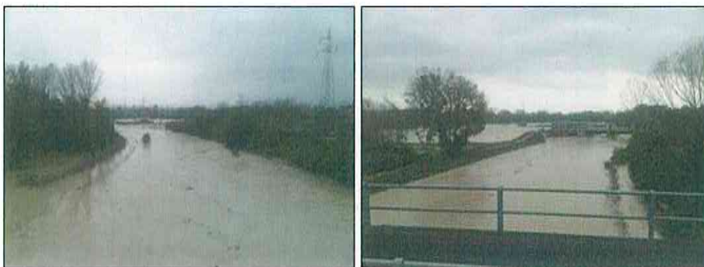
Figura 5.23 – Allagamenti a monte e a valle del ponte di via Aterno – evento 2013.
