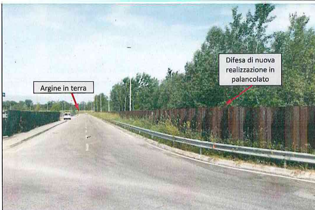
Figura 3.4 – Palancolato a completamento degli interventi realizzati per la messa in sicurezza idraulica del centro commerciale a Chieti Scalo.
