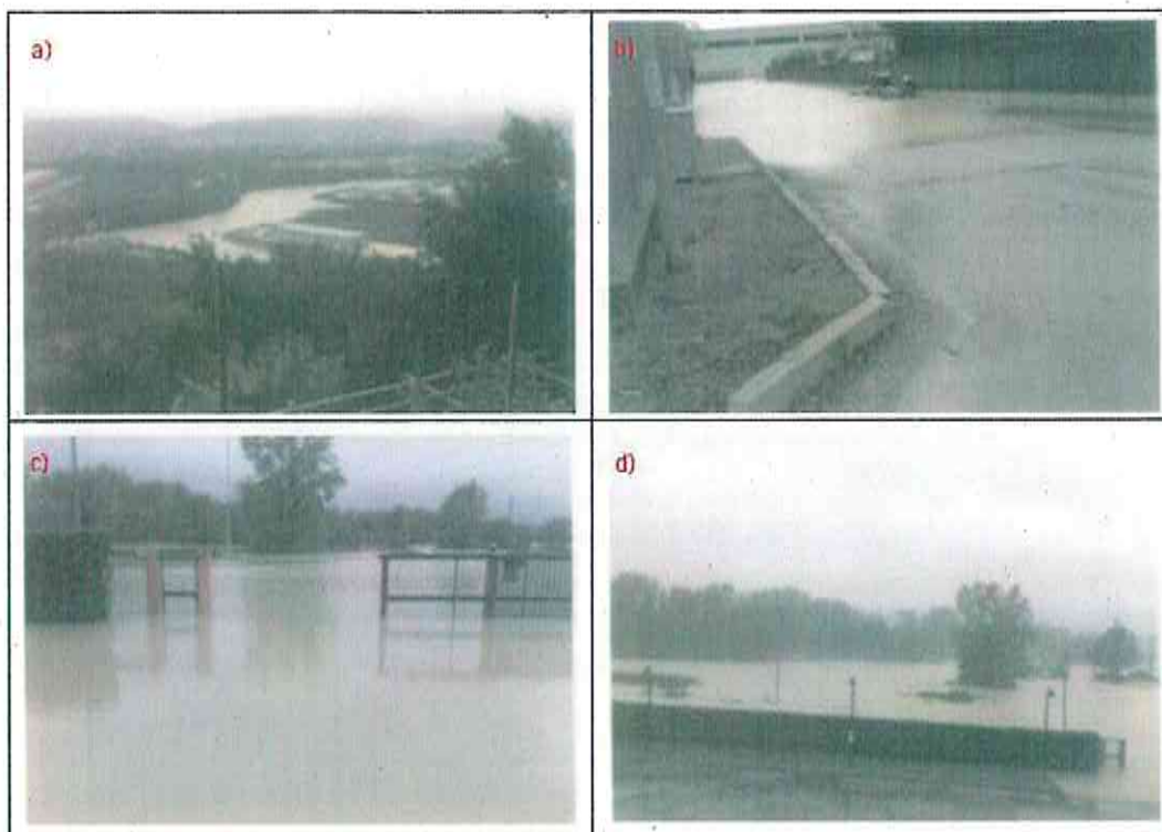
Figura 5.14 – Area interessata dagli allagamenti dell'evento 2013 con ubicazione dei coni ottici delle foto e immagini dell'evento 2013 nell'area a monte delle casse.
