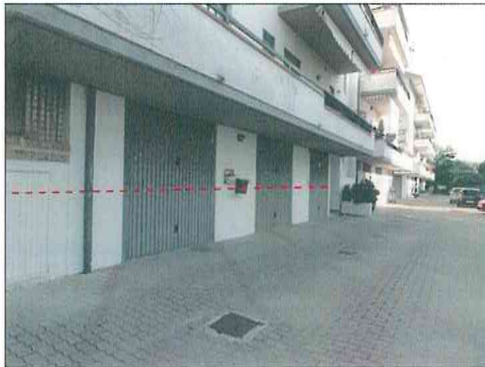
Figura 5.25 – Quartiere residenziale a Santa Teresa. Con la linea rossa si indica il livello raggiunto dall'acqua durante la piena del 2013.
