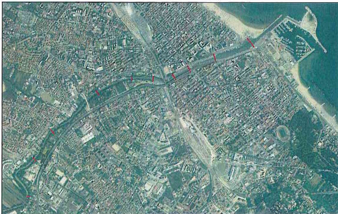
Figura 3.25 – Sezioni d'alveo rilevate nel tratto cittadino del Comune di Pescara (maggio 2016) all'interno degli "Approfondimenti e implementazioni degli studi idraulici e di morfodinamica fluviale e costiera a corredo del P.R.P. di Pescara"
