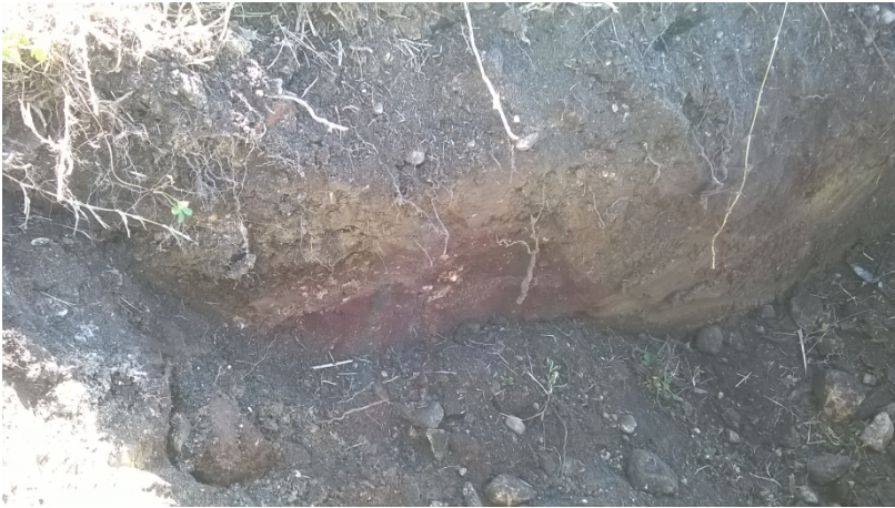
Foto 4 – Ulteriore trincea interessate dalla presenza di ceneri di pirite
