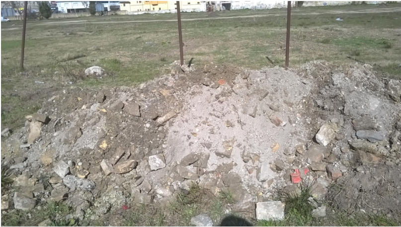
Foto 7 – Dettaglio di cumulo da trincea con materiali da demolizione
