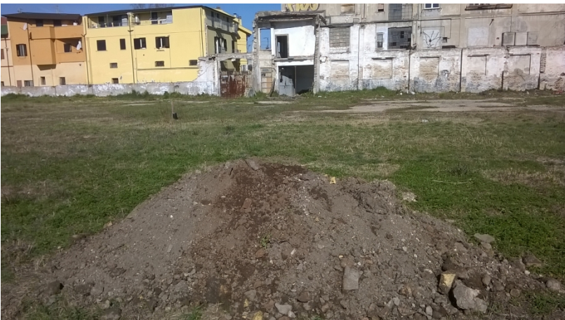
Foto 2 – Cumulo di rifiuti estratto da trincea lato nord del sito. Si osservano materiali rosso violacei, sabbie grigie e materiali provenienti da attività di demolizione
