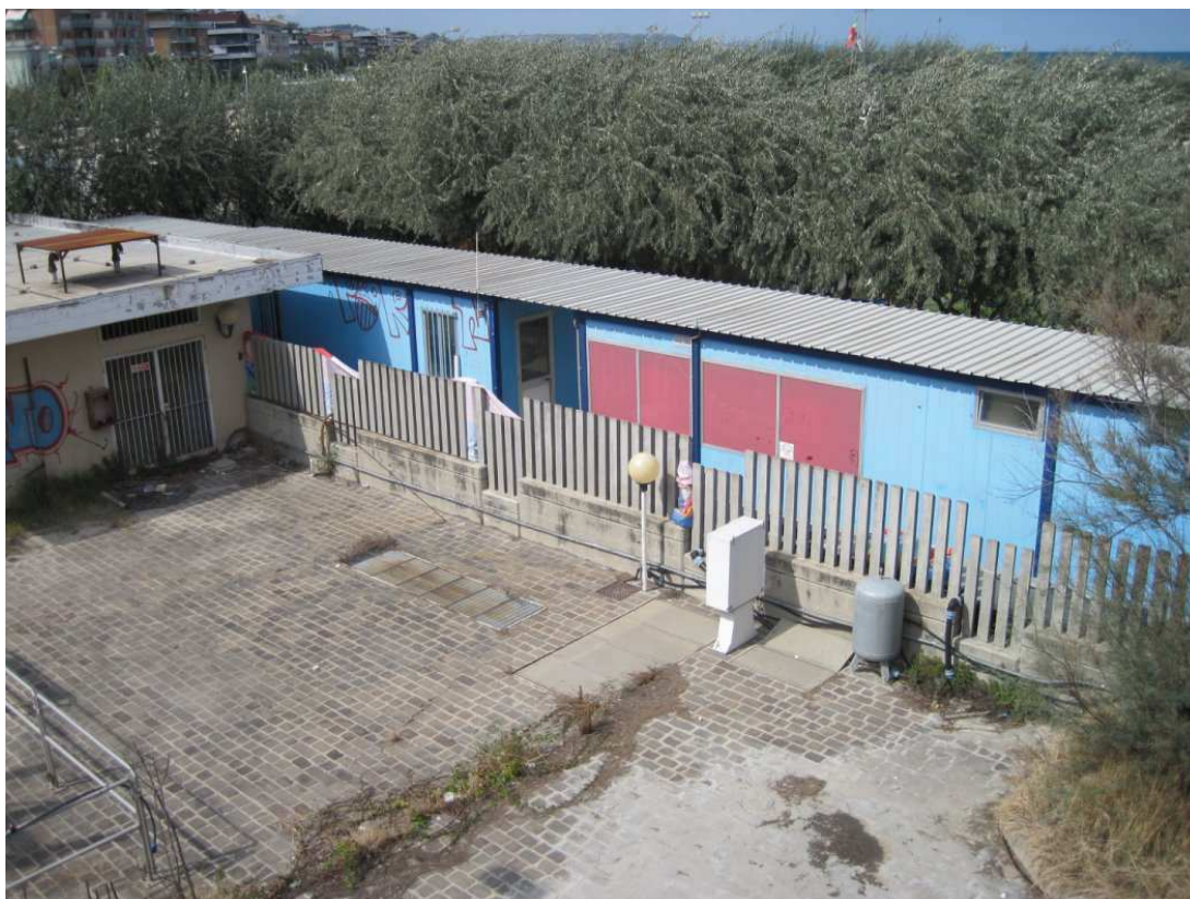
Figura 2.5 Angolo sud-ovest del sito di studio, con in primo piano l'area del depuratore, con vista dal soprastante ponte pedonale.
