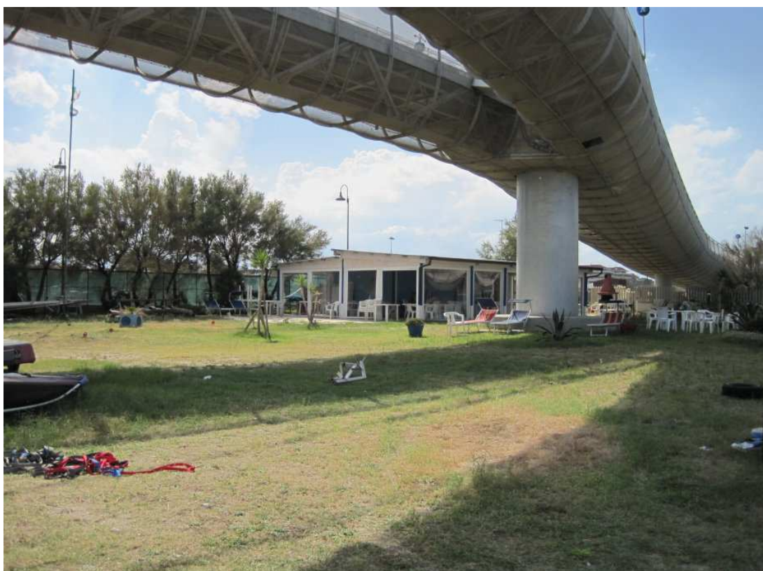
Figura 2.6 Aree della Lega Navale al di sotto del ponte pedonale, di cui è mostrato in primo piano il pilastro di sostegno; sullo sfondo la recinzione di rete e alberi.
