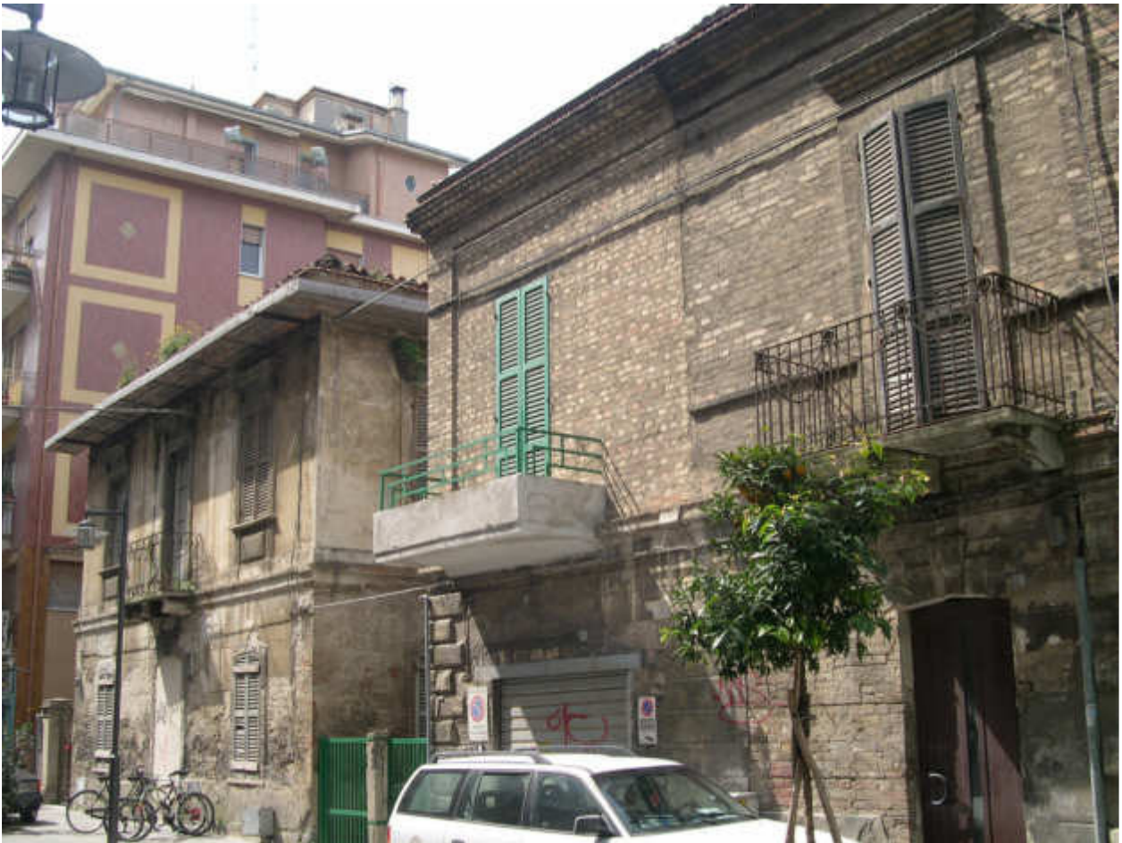
Foto. 4: vista dell'area e degli edifici da via Piave
