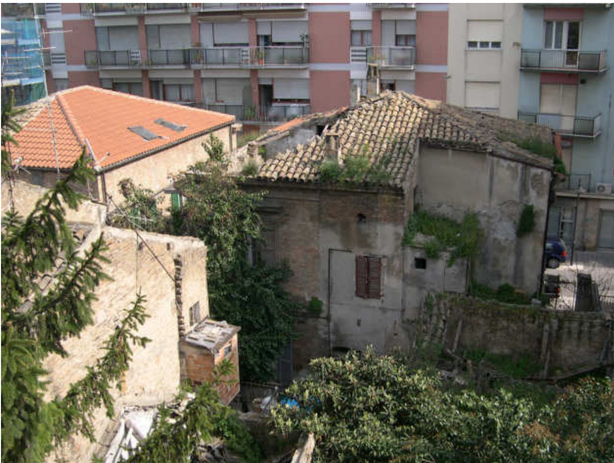
Fig. 5 vista dell'area e degli edifici dal versante interno
